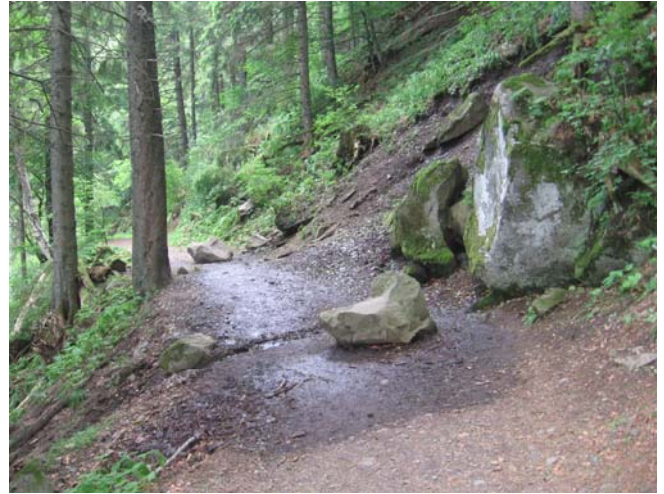
Illustration 17 : Zone 2 - Chute de bloc sur le chemin aux environs de la 5 ème et 6 ème sources
