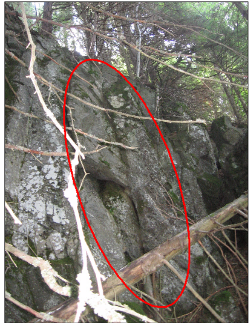
Illustration 13 : Zone 2 - Colonnes potentiellement instables à moyen terme
